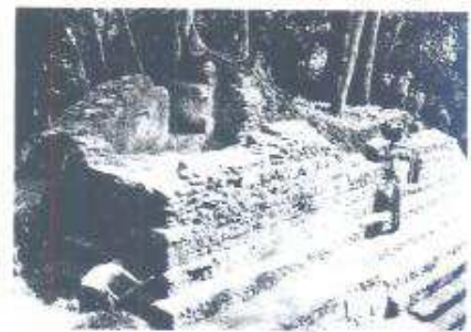
Fachada sur del edificio A-7
